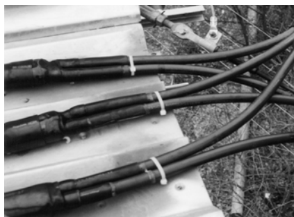
Ответительные муфты на линии СИП до 42 кВ
